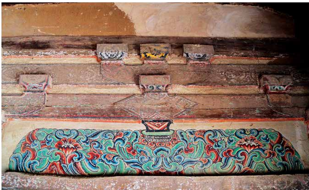
开化寺大雄宝殿补间铺作彩画实物现状照片：东壁南次间
