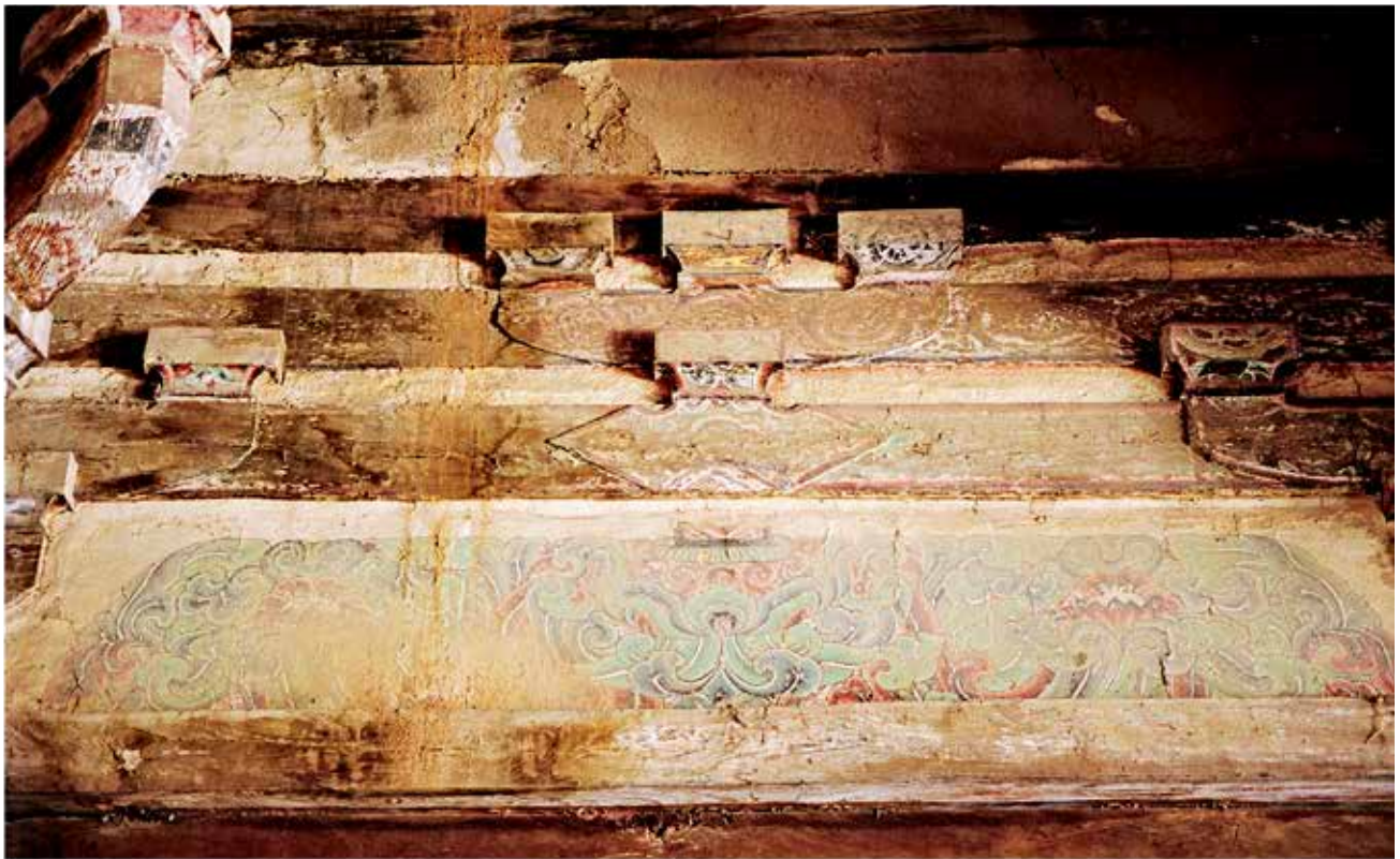
开化寺大雄宝殿补间铺作彩画实物现状照片：东壁北次间
