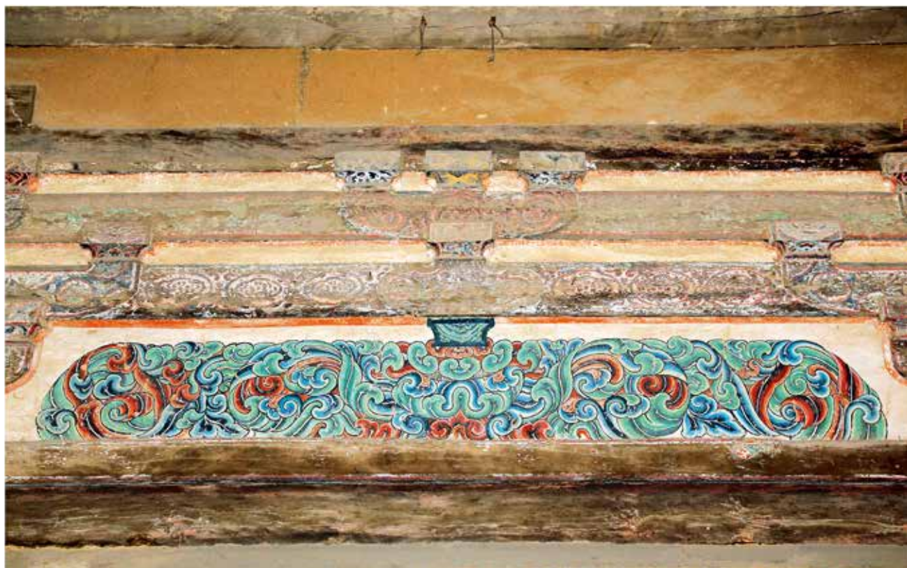
开化寺大雄宝殿补间铺作彩画实物现状照片：东壁当心间
