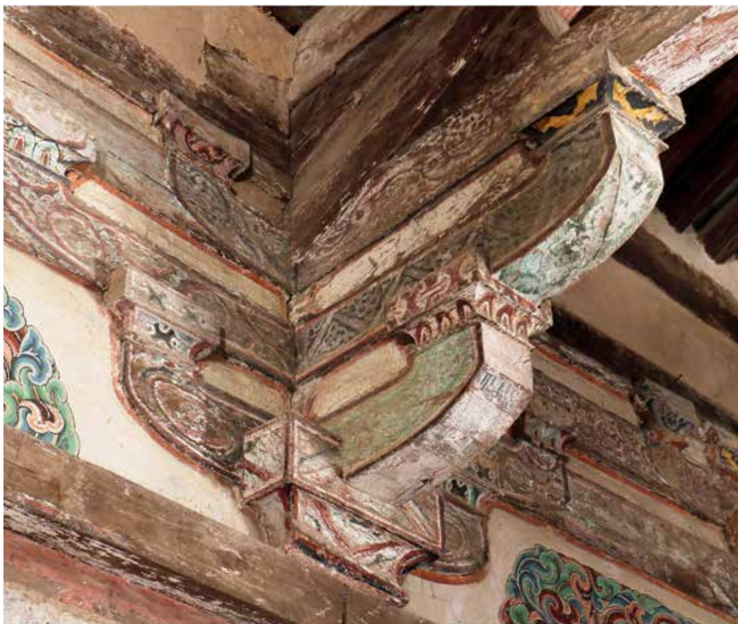
开化寺大雄宝殿柱头铺作彩画实物现状照片：1-C、4-C
